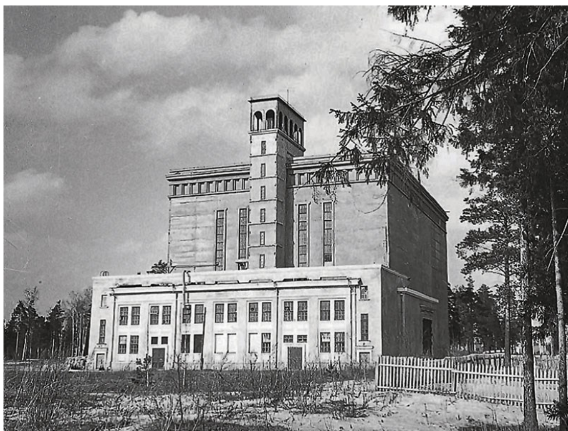
Рис. 8. Синхроциклотрон (Установка «М»), предположительно 1950-е гг. [Фотоархив ОИЯИ]
